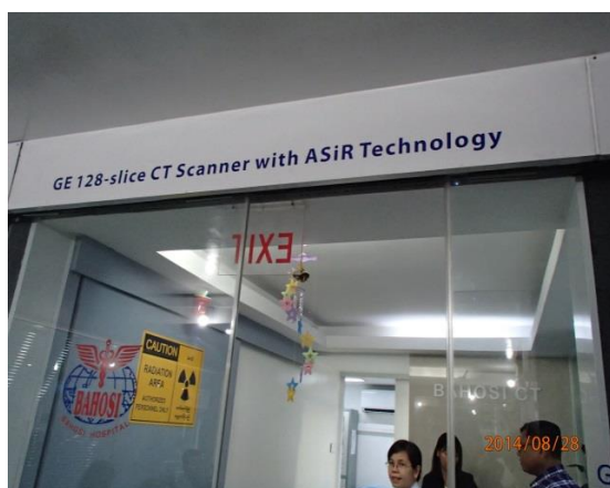
図表・39 CT Scanner 設置室
