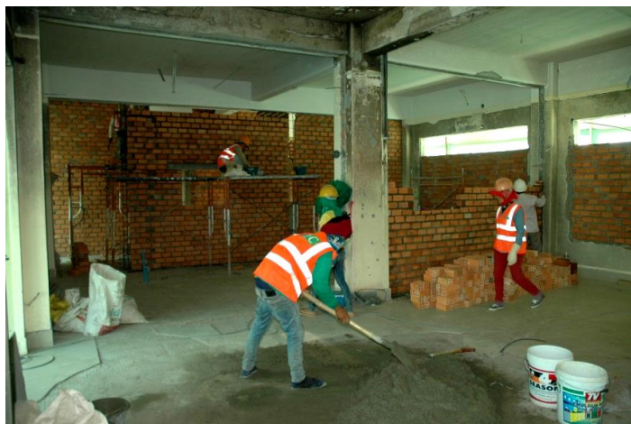
検査センター改修工事の様相
