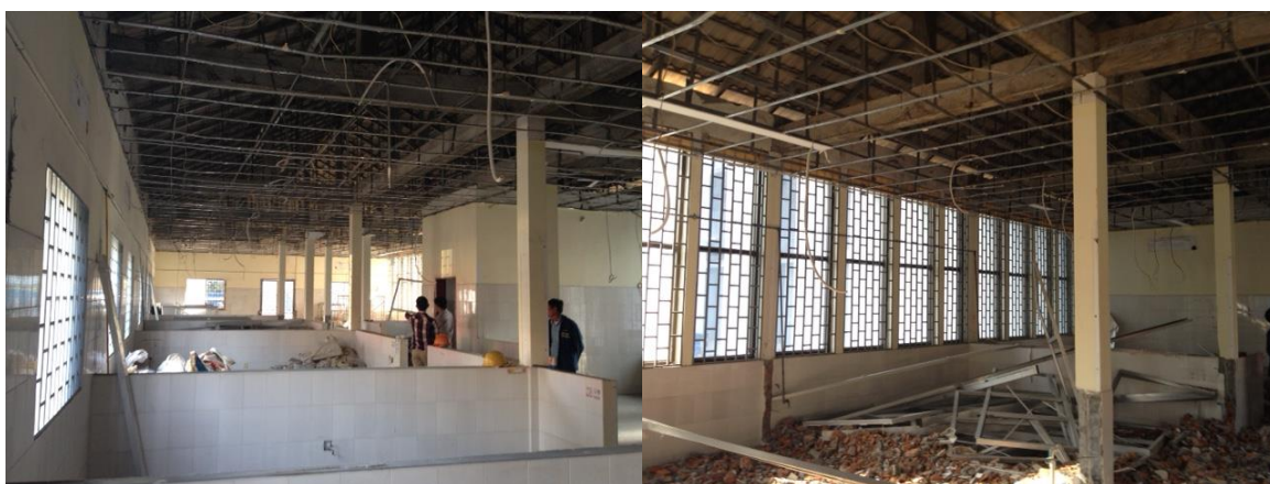
健診センター改修工事の様相
