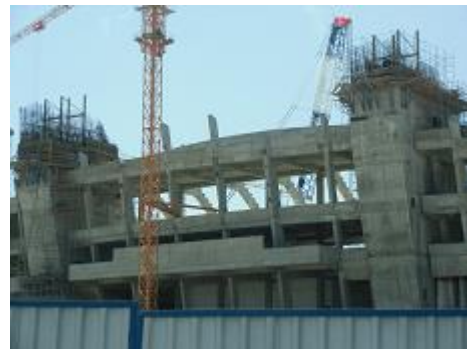
建設中のスタジアム
