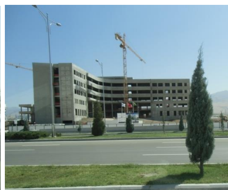
建設中のリハビリセンター
