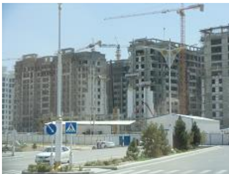
建設中の高層住宅
