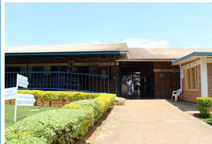
ニヤマタ地区病院の外観
