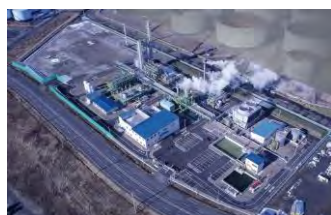
CO2分離・回収・貯留施設
