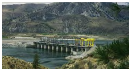
水力による水素製造施設
