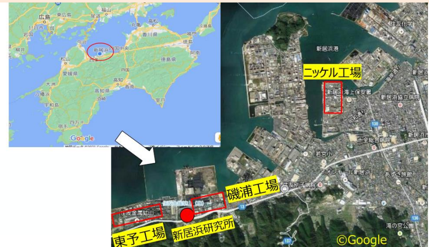
住友金属鉱山 中規模実証設備構築拠点
