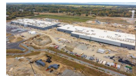
米国・ノースカロライナ州に建設中の工場
