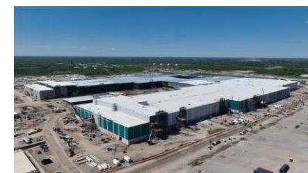
米国・カンザス州に建設中の工場
