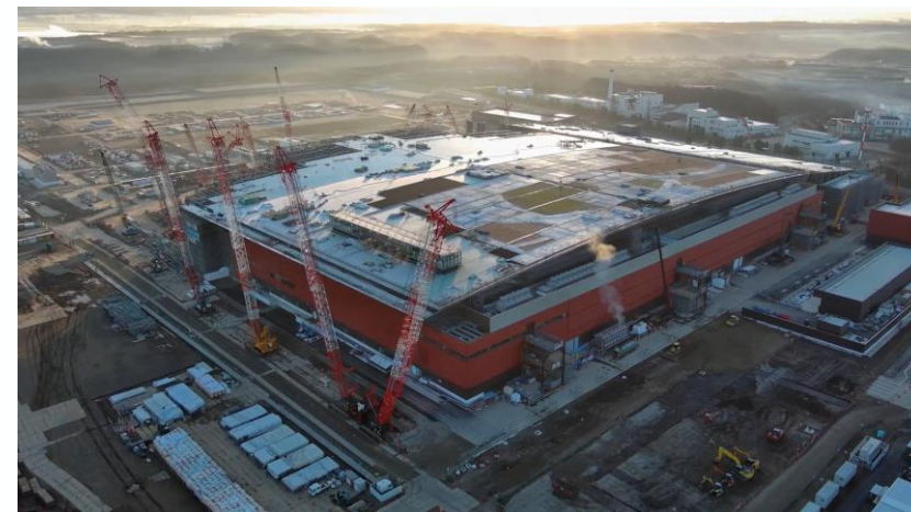
IIM建設状況 (2024年11月12日時点)
