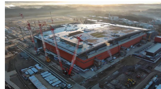
建設中の試作ライン（北海道千歳市）
