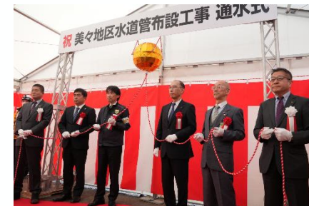
上水管布設工事の通水式 (出所) 千歳市HP
