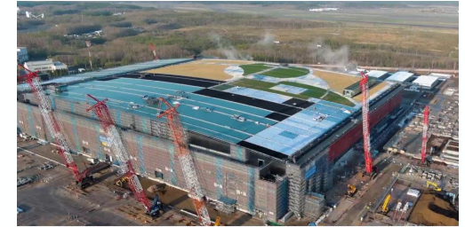
建設中の拠点（北海道千歳市）
