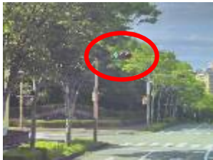
写真3 信号を覆う街路樹 (兵庫県三田市)
