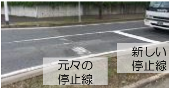
写真2 停止線位置の変更 (福岡県北九州市)
