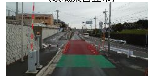
専用道の設備（茨城県日立市）19
