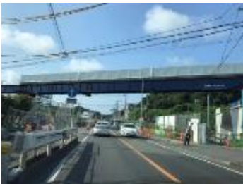
写真1 道路工事によるGPSへの影響 (神奈川県横浜市)
