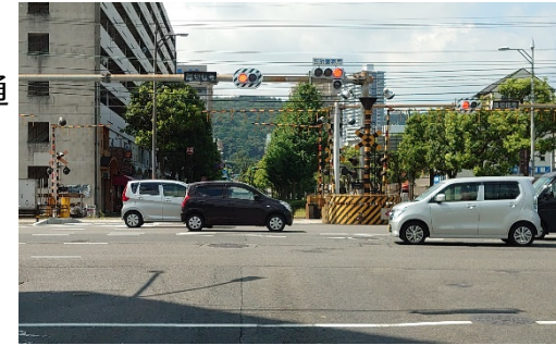
踏切箇所（滋賀県大津市）
