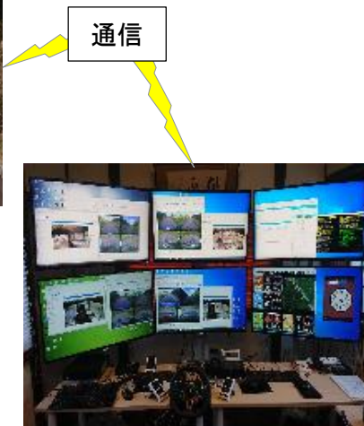
遠隔監視・操作室
