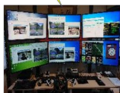
遠隔監視・操作室
