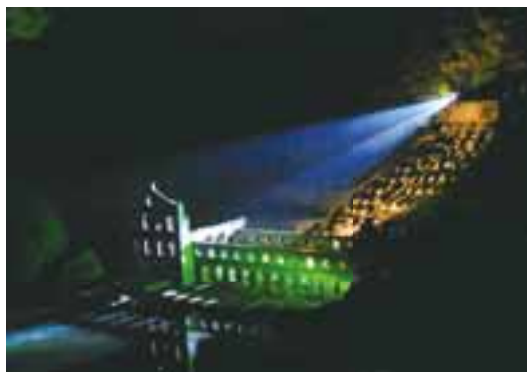
鹿児島県伊佐市の曾木第二発電所のライトアップ
