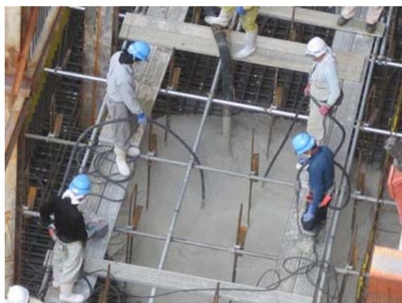
図 2-3-10 クリーンクリートの施工状況(紀尾井町プロジェクト住宅棟)
