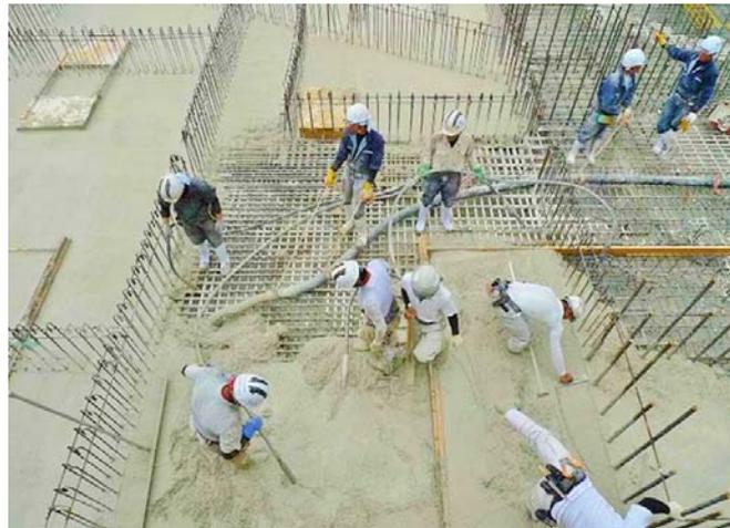
図 2-3-6 ECM セメントの施工状況
