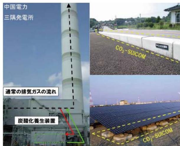
CO<sub>2</sub>-SUICOM炭酸化養生装置と適用先
