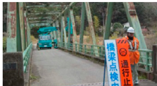
特殊車両を用いた橋梁点検。幅員の狭い橋梁では通行止め等の交通規制が避けられない
