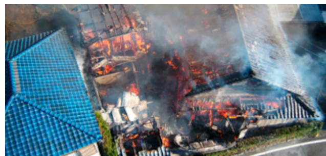
2017年の建物火災。空撮映像の活用に加え、ヘリコプターとの空域管理も順調に行うことができた
