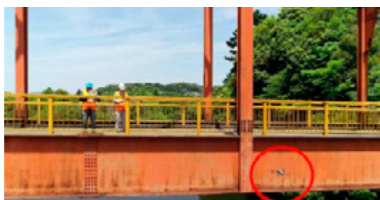
ドローン橋梁点検の様子。人が立ち入りにくい場所や高所に架かる橋の点検に重宝している
