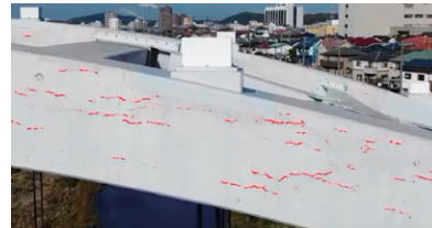
AI診断画像(赤い部分が損傷部)
