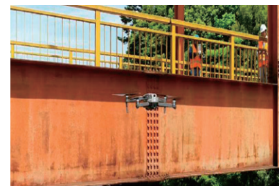
老朽化が進む橋梁のドローン点検
