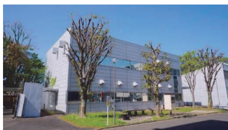
解体建物：電磁環境実験棟
