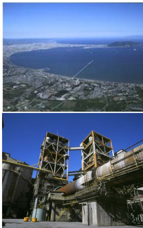
海上栈橋を含む遠景(上)、上磯工場(下)
