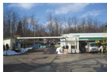
パイプを使って放出される断熱材フロンを隣接の中間処理施設に送り有効活用している。
