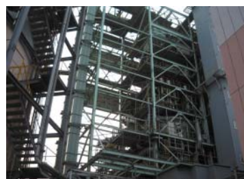
製鉄業の高炉と同じ仕組みである。鉄鉱石の代わりにRDFを投入する。
