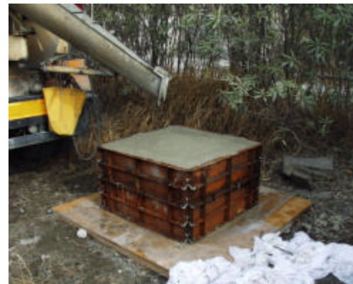
写真 コア用型枠 (打設済み)
