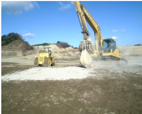
写真 固化材散布の様子
