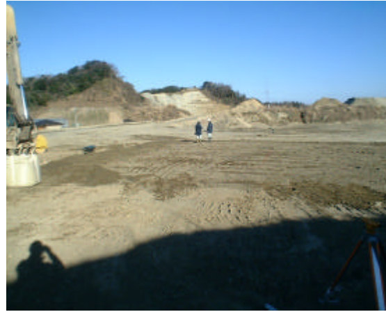
写真 試験土敷き均し後の様子
