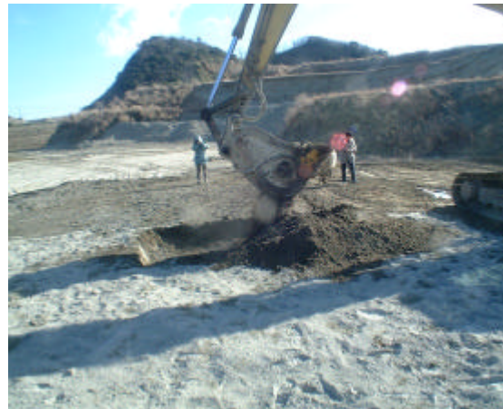
写真 固化材の攪拌・混合の様子
