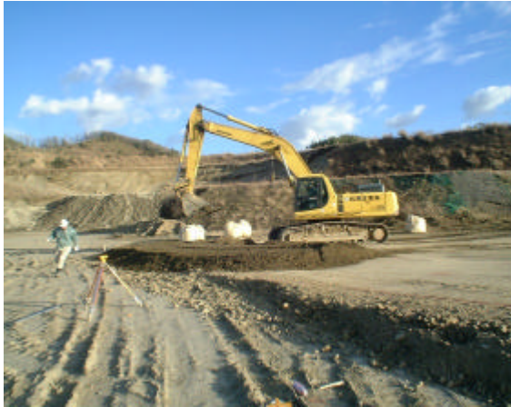
写真 試験土撒き出しの様子
