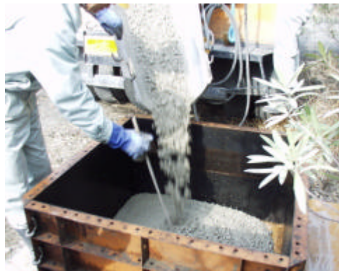
写真 コンクリートのコア用型枠への打設
