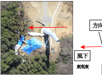
写真 1 ブレード、ナセル脱落状況
