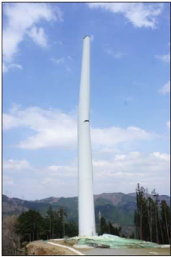
写真 1 ブレード、ナセル脱落状況
