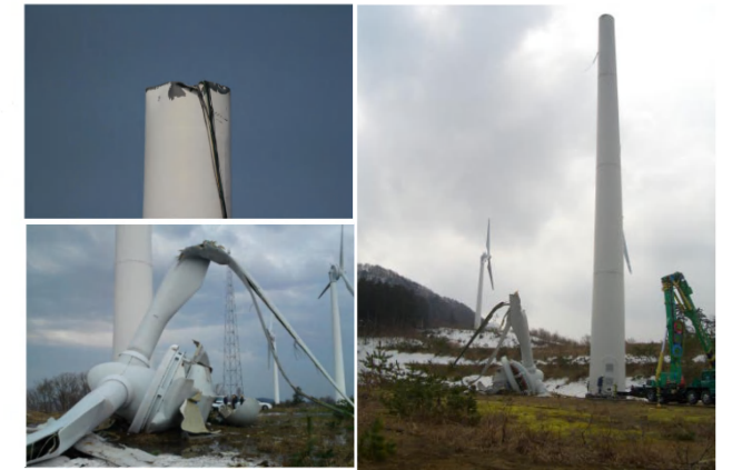
写真1-1 ナセル落下とタワーの破断状況
