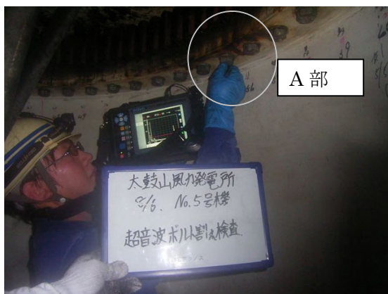
a) 探傷状況全景
