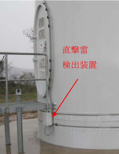
図 3 直撃雷検出装置
