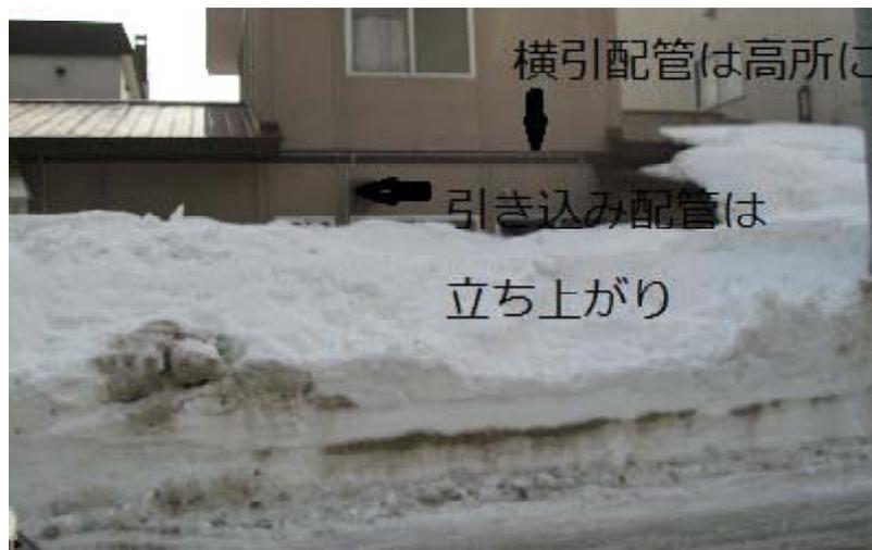
図3. 1 配管施工例
