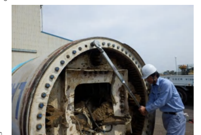
写真3-2 事故機ボルトの調査状況
