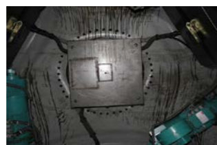
写真2 ハブ内部状況
