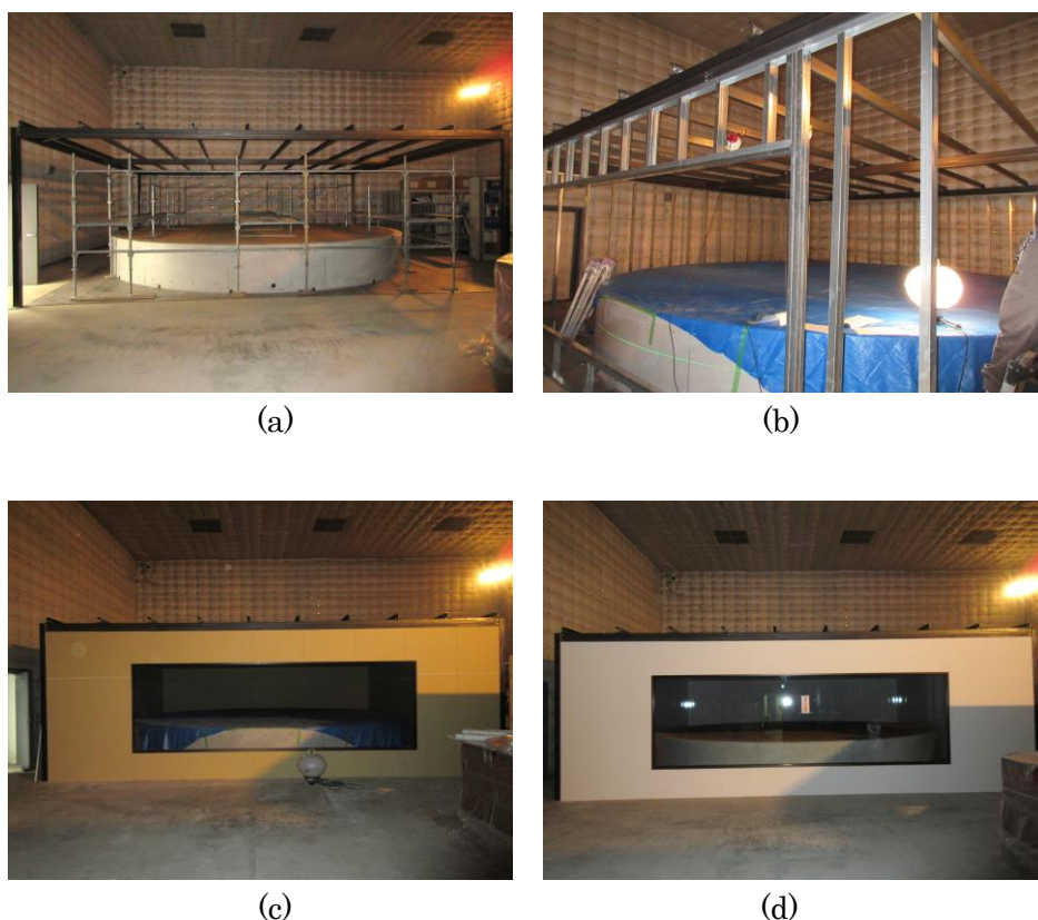
図 4-1-3 気密ブースの製作工程
