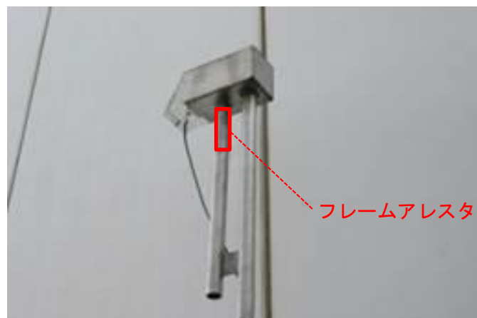
図 4-1-14 フレームアレスタ内蔵排気口外観
