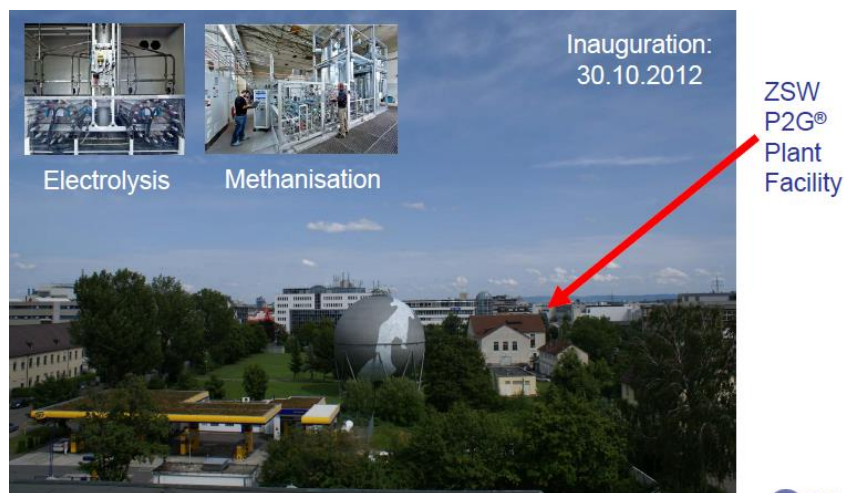
図 1. 4. 2 実証プラント
