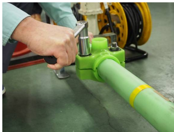
図 4-14 鋼管用サドルの施工状況②
