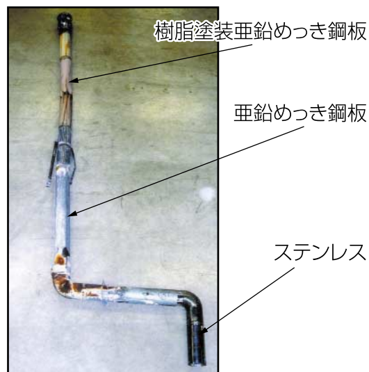
継ぎ足した排気筒の状況は
