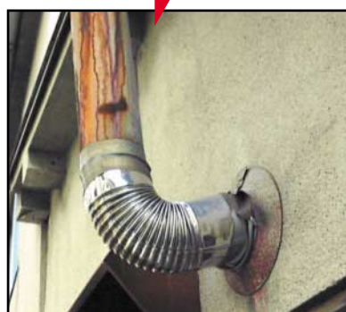
屋外の曲がりのみをステンレス製に交換したが…
