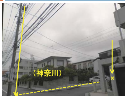
66kV架空送電線と架空配電線
