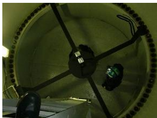
3D レーザースキャナー設置確認状況
