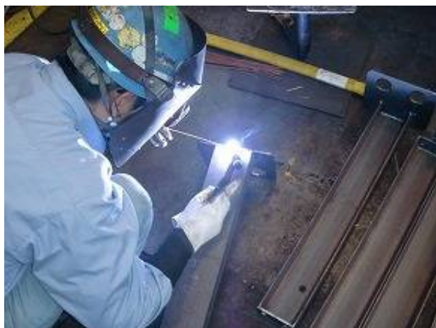
クロスゲージ製作状況 溶接
