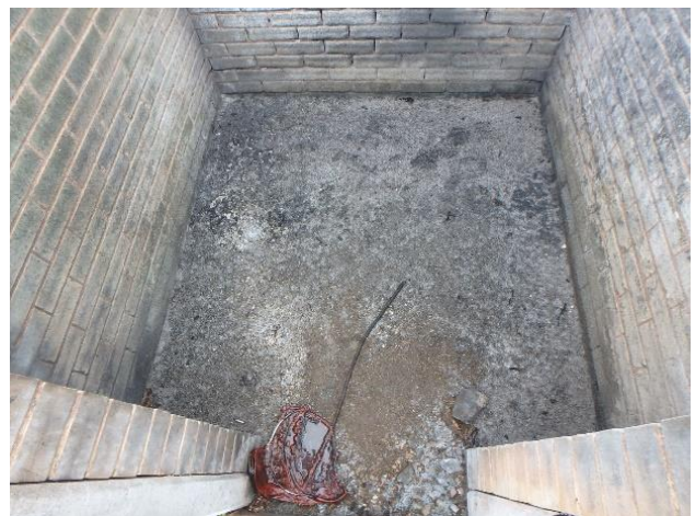
図 3 廃薬焼却場の内部（図の下側が出入口）
