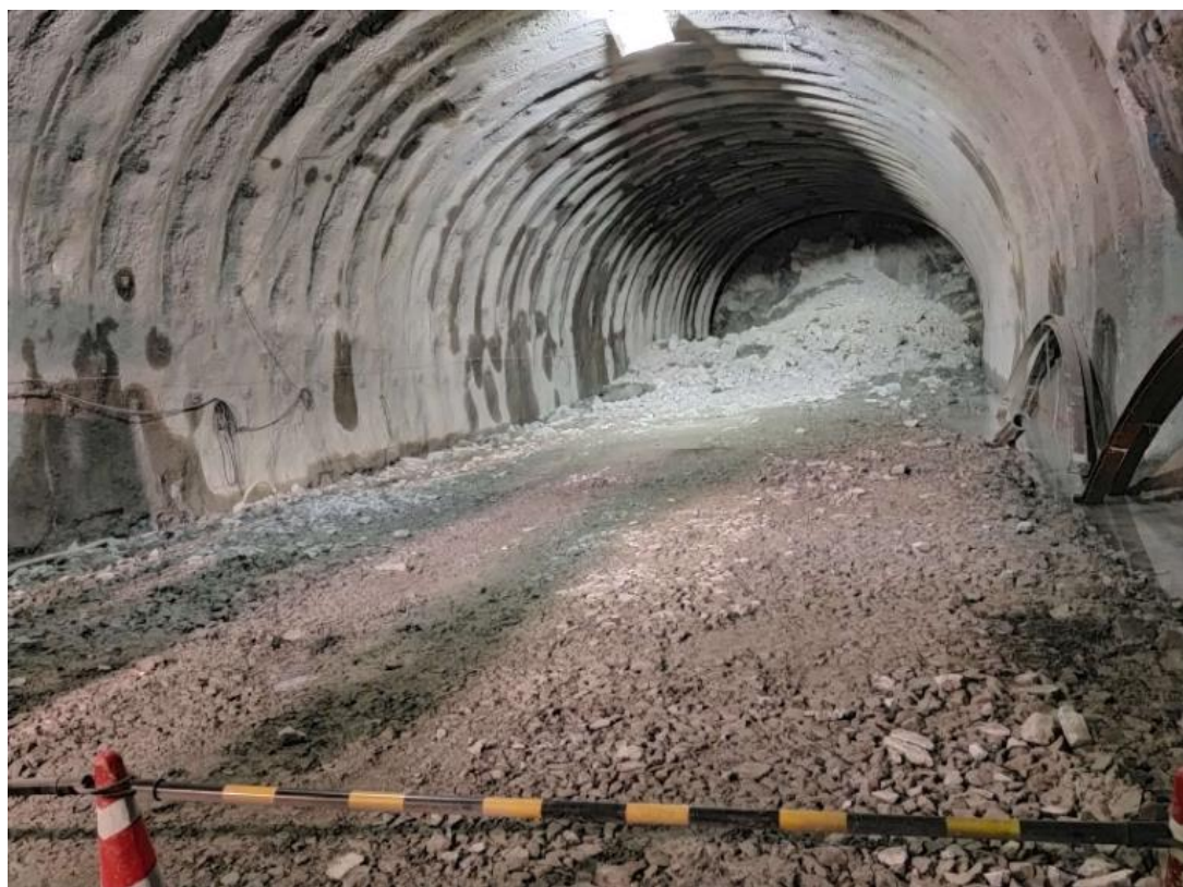
写真2 切羽（発破場所）
