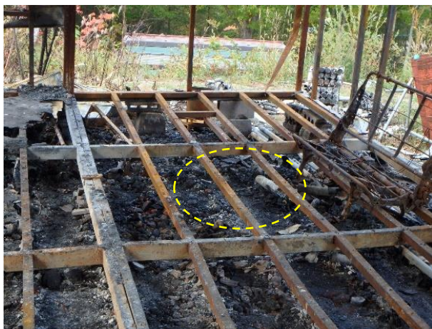
図 8 コントロールパネル発見場所（西物置内）
