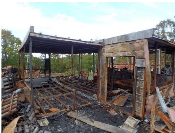
図2 西物置外観 (南西側から撮影)
