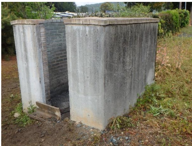
図 2 廃薬焼却場の外観
