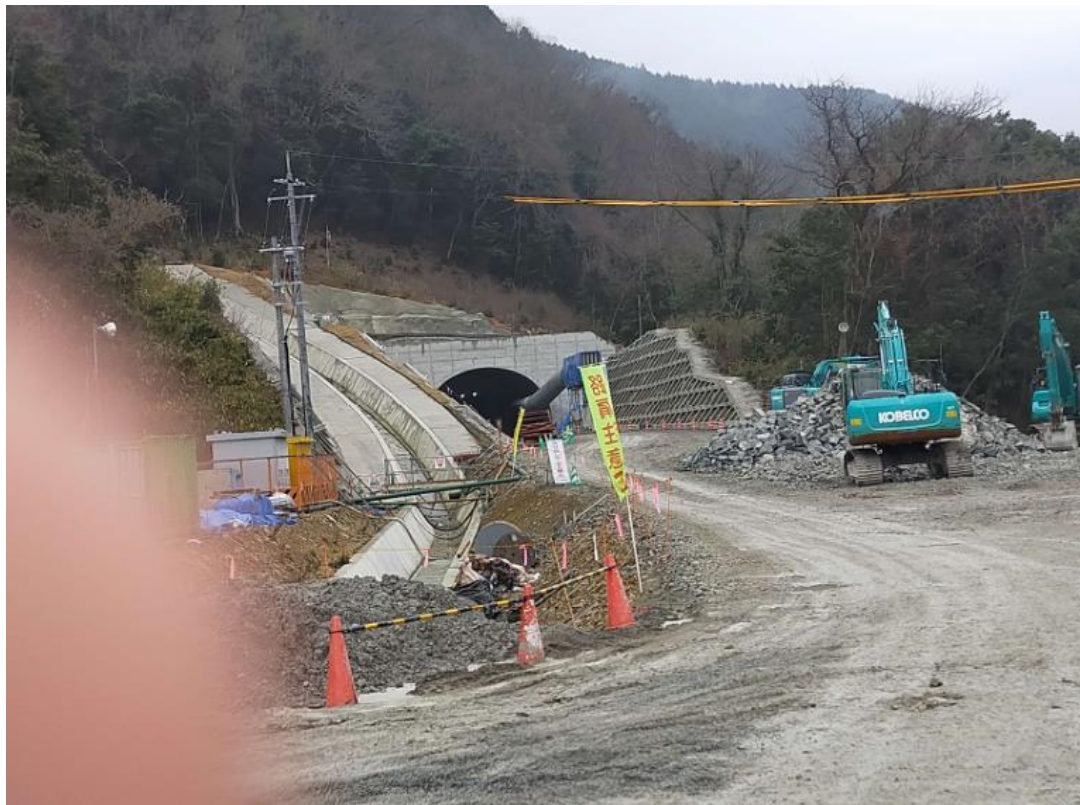
写真1 トンネル工事現場
