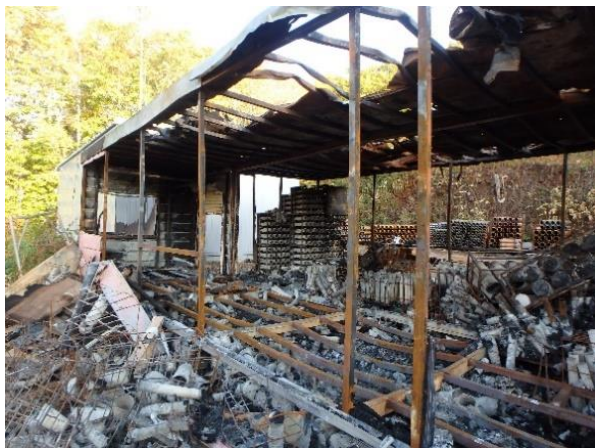
図 16 中央物置内と屋根の状況
