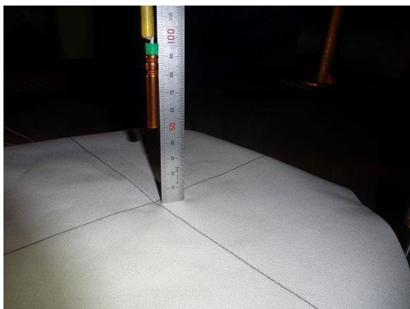
雷管設置状況
