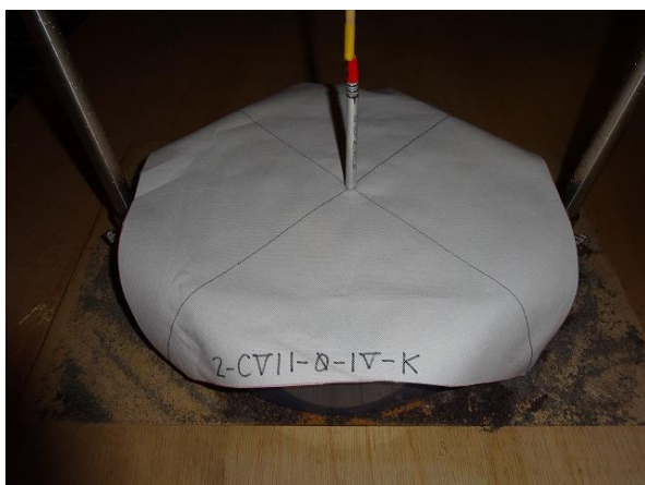
雷管設置状況
