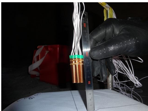
雷管設置状況 1
