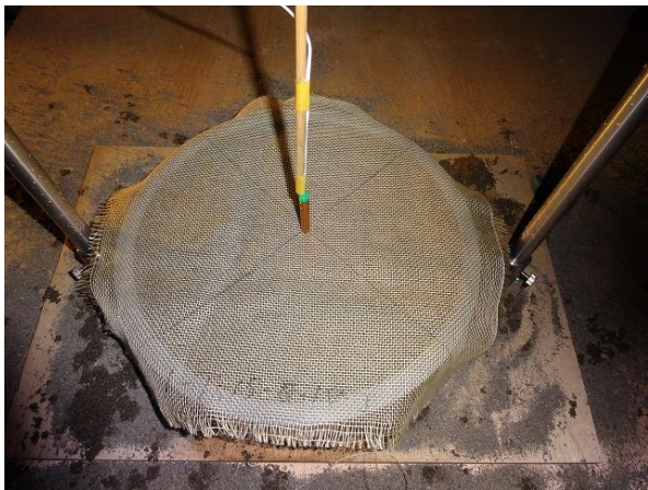
雷管設置状況
