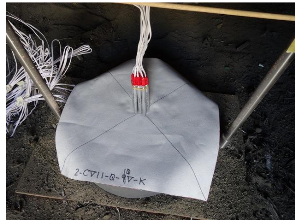
雷管設置状況 2
