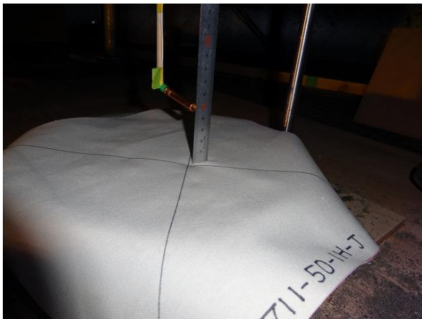
雷管設置状況
