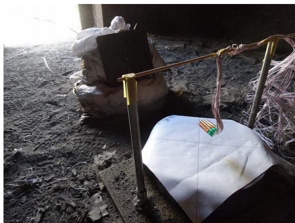
雷管設置状況 2
