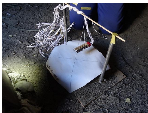
雷管設置状況 2
