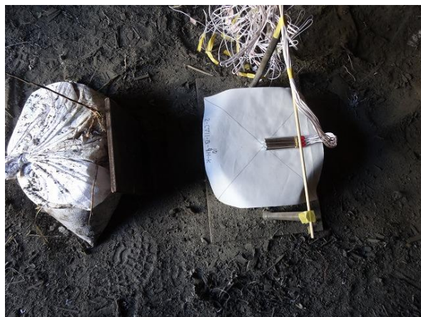
雷管設置状況 2
