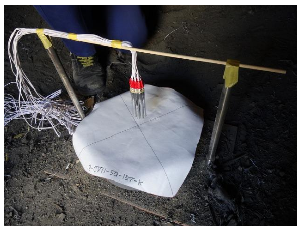
雷管設置状況 2
