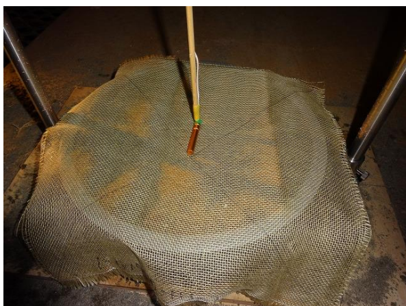
雷管設置状況
