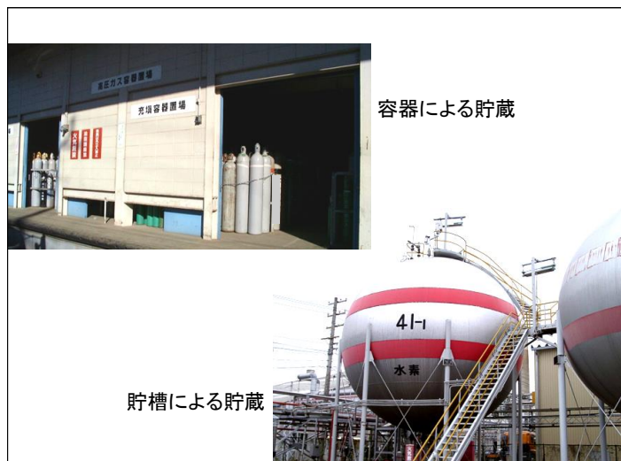
図Ⅱ-18 高圧ガスの貯蔵
