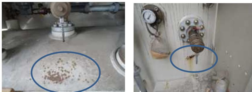
図 6.2.1-9 被試験体 A-4 及び A-5 の外部表面さび
