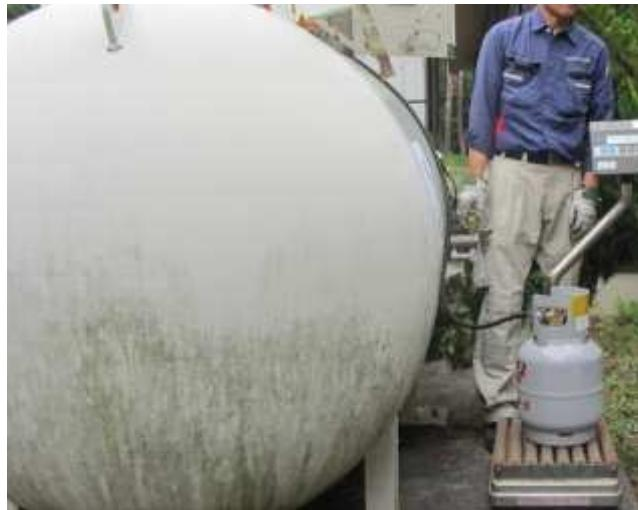
図 6.1.2-2 小型容器への残留ガスの液移送（例）
