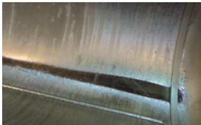
図 6.3.1-2 経年バルク貯槽内部にドレン分が残留している状況
