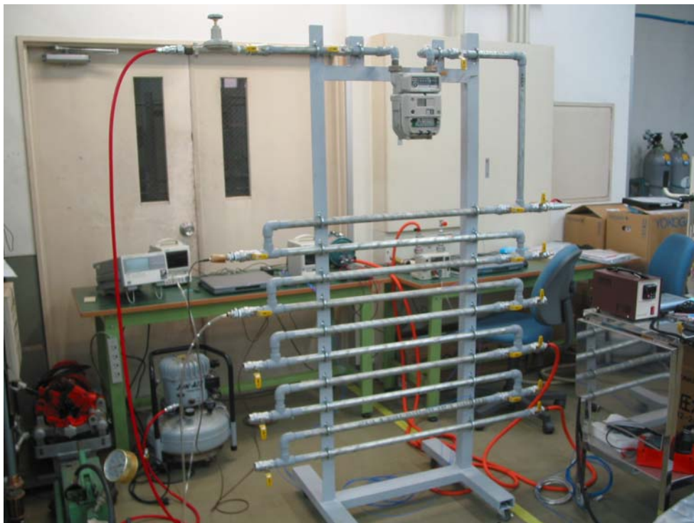
写真 7.1.2.2 LPガス配管モデル
