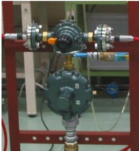
写真 7.2.1.4 自動切替式一体型調整器 (30kg)
