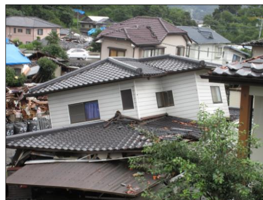
倒壊した住宅（益城町）
