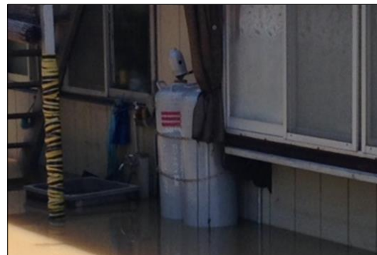
鎖の二重掛けによって容器流出を免れた事例
