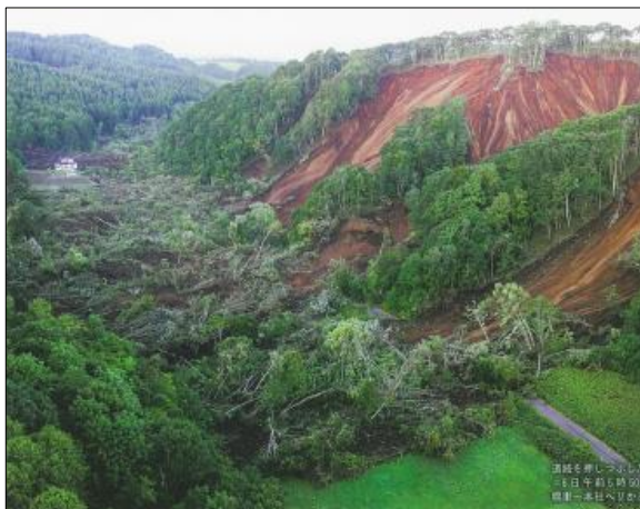
広い範囲で土砂崩れが発生
