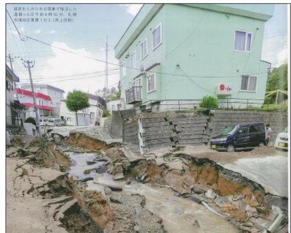
液状化により地盤沈下が発生
