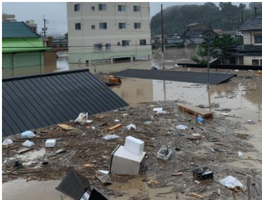
平屋の家屋は屋根まで水没した
