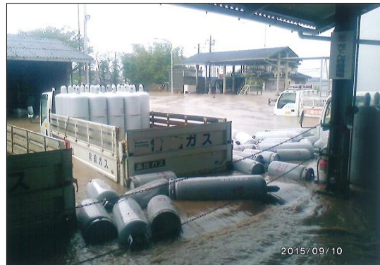
プラットフォームまで浸かった充填所 (茨城県高圧ガス保安協会提供)
