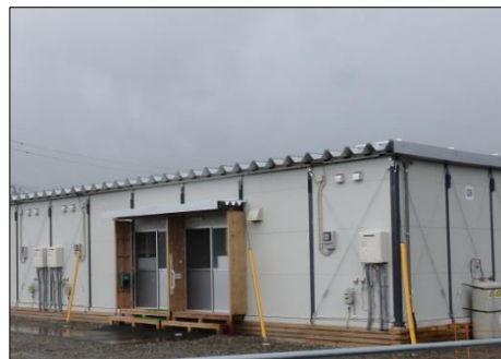
仮設住宅の建設 (写真：熊本県LPガス協会提供)
