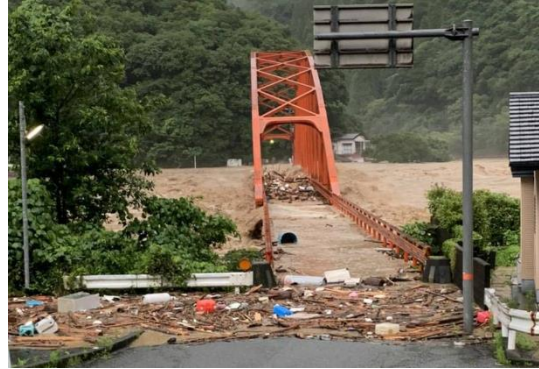
人吉市を抜けた球磨川の 狭窄部 で急速に水位が上昇し、濁流で深水橋も流された
