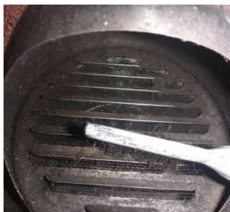
給気口の清掃の様子
