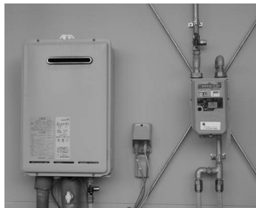
仮設住宅での給湯器設置
