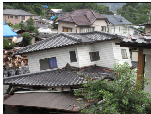
倒壊した住宅（益城町）
