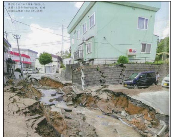
液状化により地盤沈下が発生
