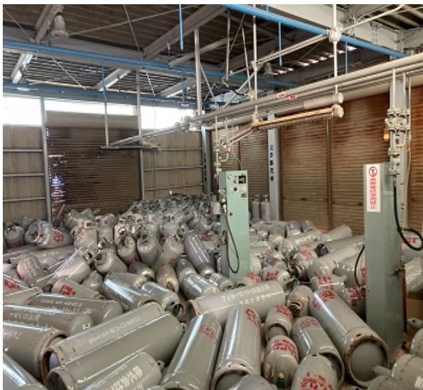
充填所で転倒したLPガス容器
