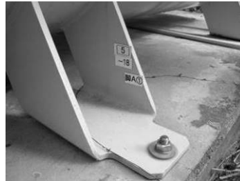
図1.24 バルク貯槽の固定例
