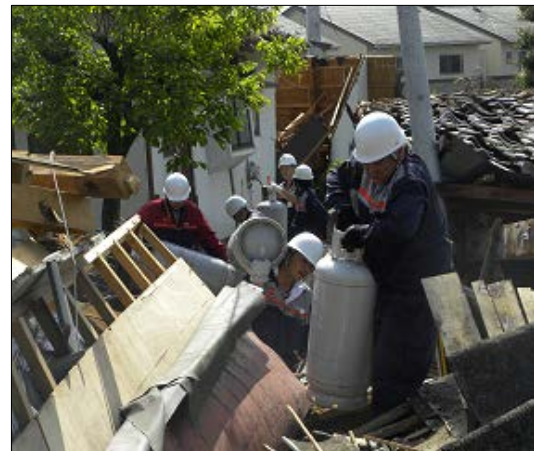
瓦礫の中から LP ガス容器を撤去
