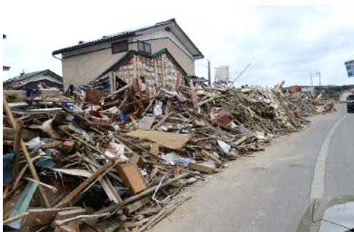
珠洲市宝立町の津波被害
