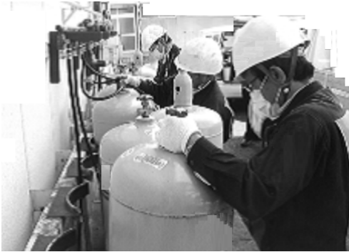
避難所にLPガス供給設備を設置
