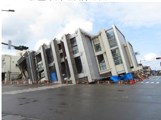
輪島市の倒壊した7階建ビル
