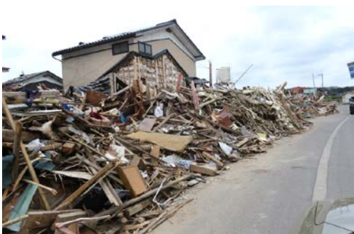
珠洲市宝立町の津波被害
