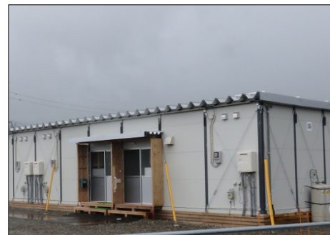
仮設住宅の建設
