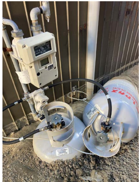
液化化現象により埋没、転倒したLPガス容器
