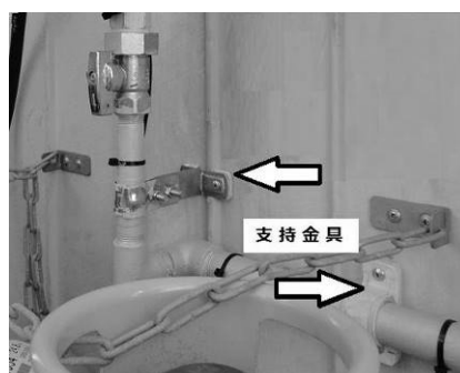
図1.15 配管支持金具例
