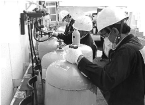
避難所にLPガス供給設備を設置
