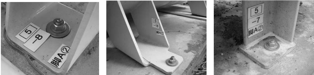
図1.24 バルク貯槽の固定例
