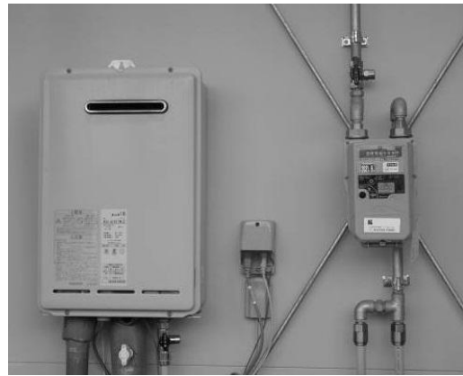
仮設住宅での給湯器設置
