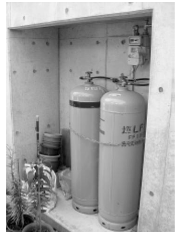
建物凹み部分への設置
