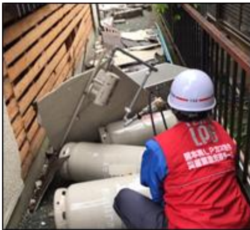
チーム LPG による応急点検
