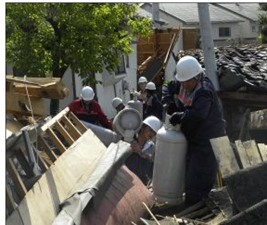
瓦礫の中から LP ガス容器を撤去
