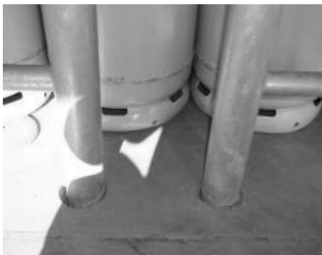
プラットホームの床面に穴をあける
