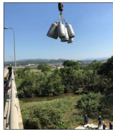
容器の回収にはクレーン車も用いられた (写真：岡山県 LP ガス協会提供)
