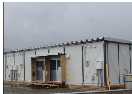
仮設住宅の建設
