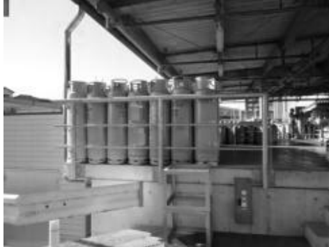
取り外し可能な柵をもうけ、プラットホームの 有効的な利用を図る。
