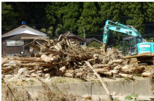
大谷川からの流木が流れ込んだ珠洲市大谷町
