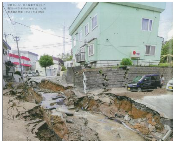
液状化により地盤沈下が発生
