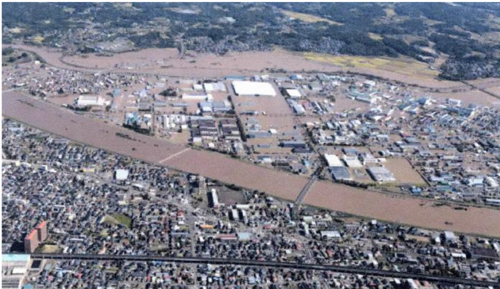
郡山市の中央工業団地は全域が冠水した
