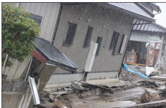
濁流により土台の傾いた住宅
