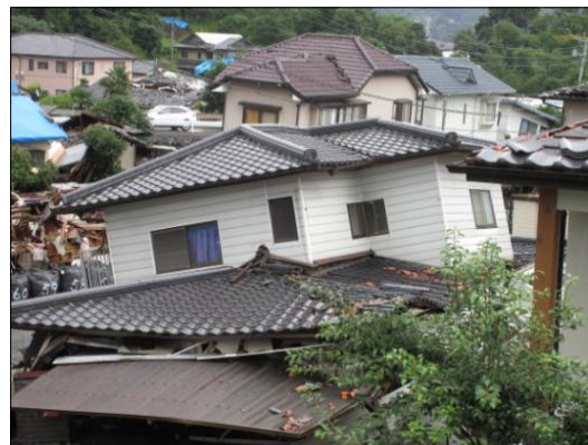
倒壊した住宅（益城町）
