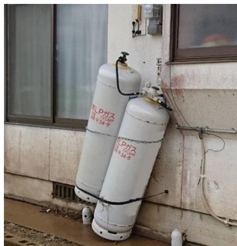
2重掛けを行った容器は水流の影響を受け ても流出することがなかった
