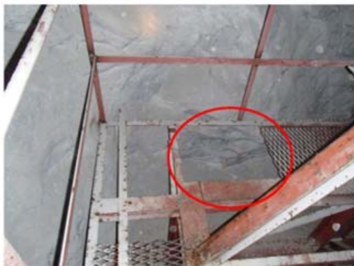
災害発生箇所 (赤枠の開口部)
