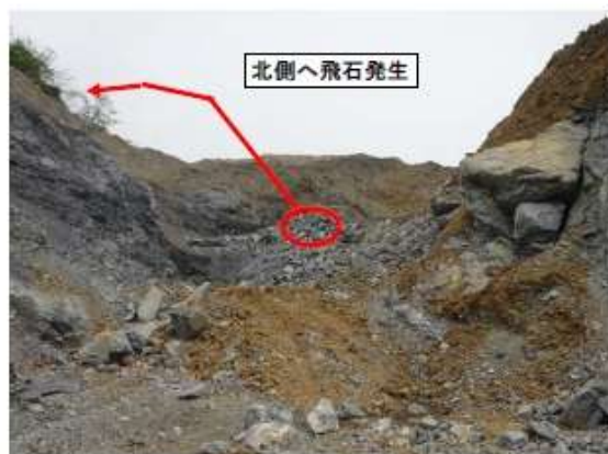
南側より北側を望む
