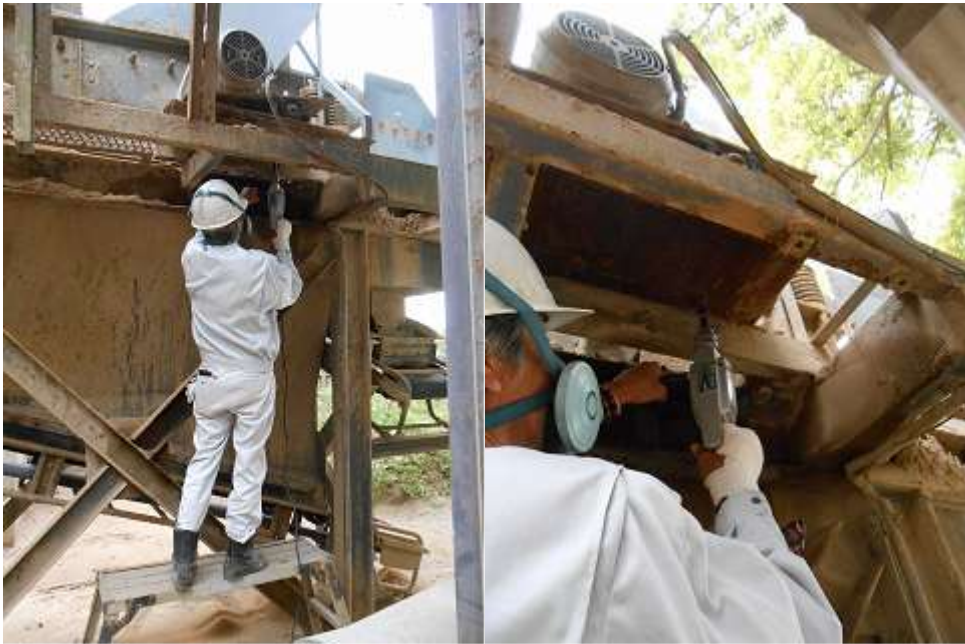
取付時の状況
