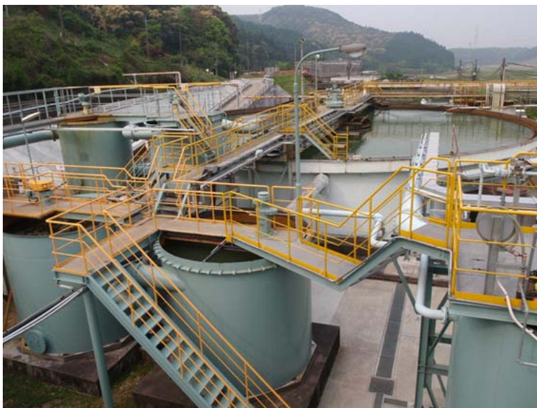
・坑廃水処理施設
