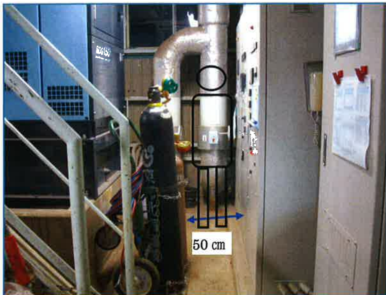
制御盤前写真
